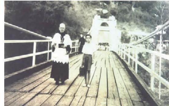
En 1872 se construyó el puente de Los Suspiros, por Timoteo Gutiérrez, aunque tuvo varias etapas y por algunos años se siguió usando una tarabita o canasta para pasar el río Bogotá. El puente de hierro data de 1885. Pero si bien su estructura era metálica, el camino era de tablas que se dañaban con frecuencia y obligaban a utilizar nuevamente la tarabita.
